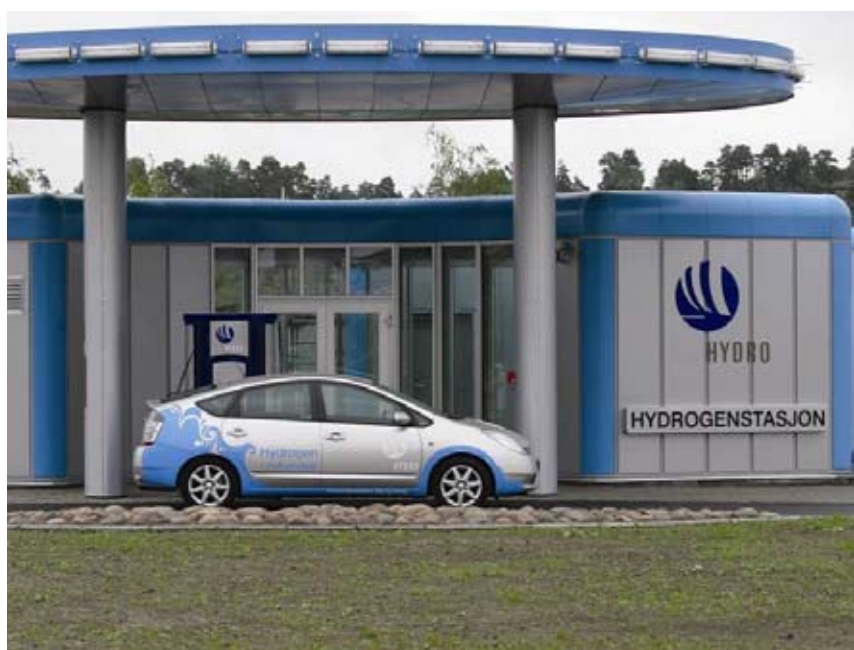
De skandinaviske lande har etableret et netværksamarbejde, der skal gøre det muligt at etablere en sammenhængende brint infrastruktur i de tre lande. Foto: StatoilHydro
